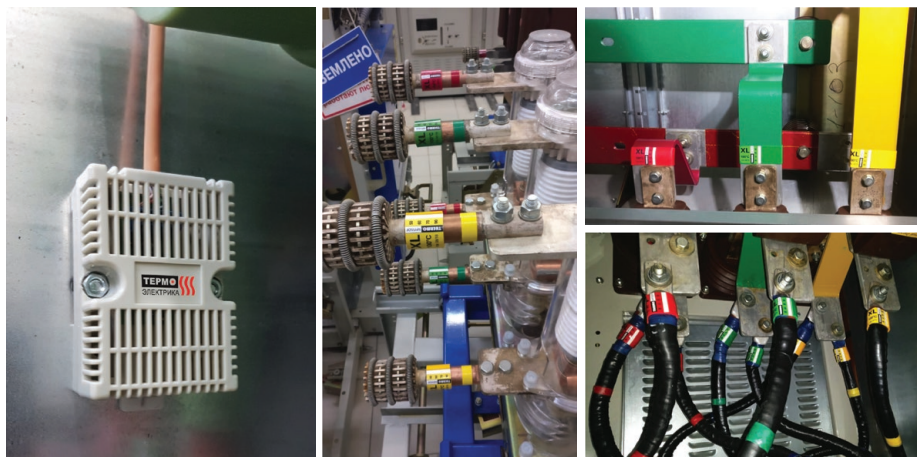
ПРИМЕР ИНСТАЛЛЯЦИИ СИСТЕМЫ В ЯЧЕЙКУ РМ6
